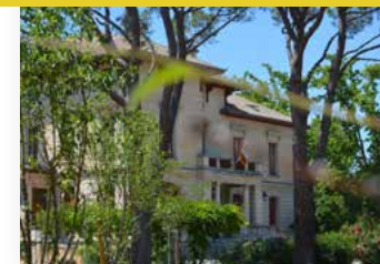
▲ Vue de l'hôtel de ville (source : Mairie du Pontet)
